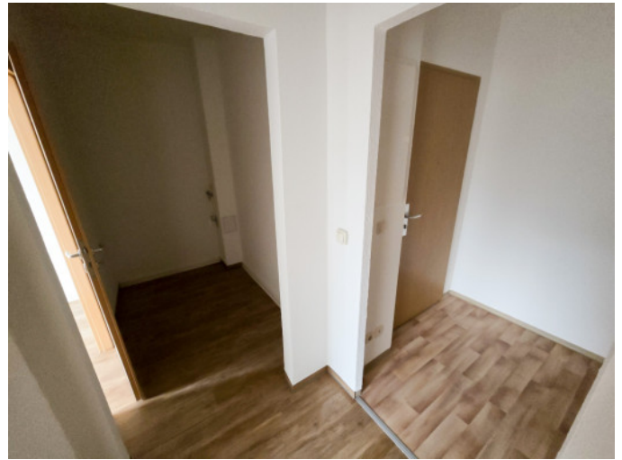
WM-Anschluss im Flur
